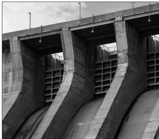
Рис. 1. Плоские затворы плотины
